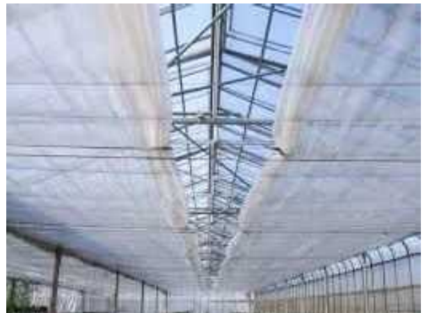
写真 33 内張りカーテンを開放し、屋根面の融雪を促す
