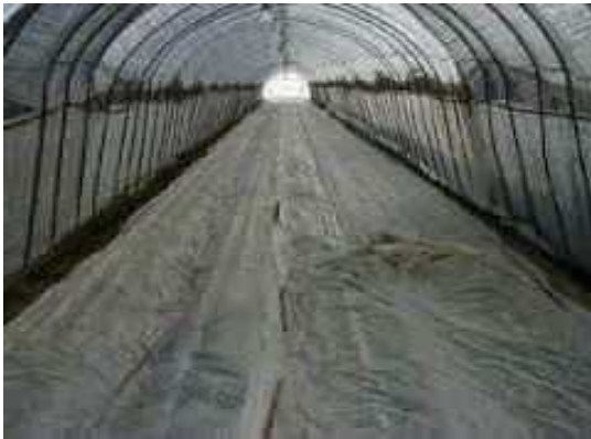
写真 49 被覆資材を修復後（奥側）に、緊急的にべたがけ被覆により保温した状況
