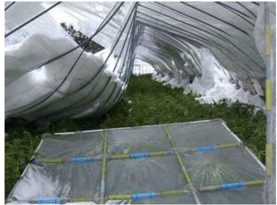
写真46 倒壊したハウスの状況 (内側)
