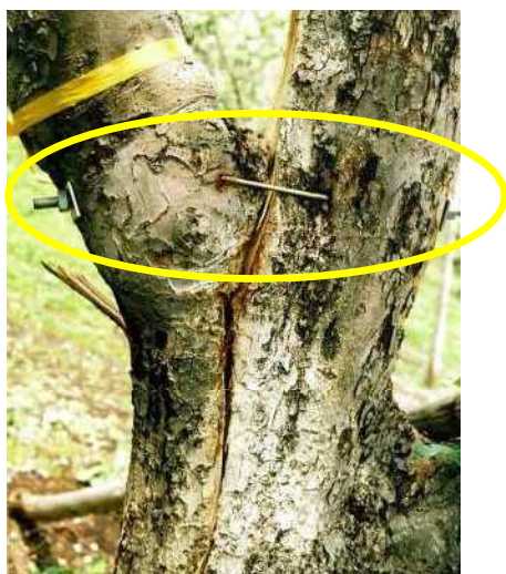
写真 43 ボルト、カスガイによる固定状況
