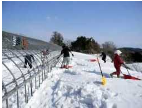
写真 35 被覆資材を除去した ハウスの除雪の状況
