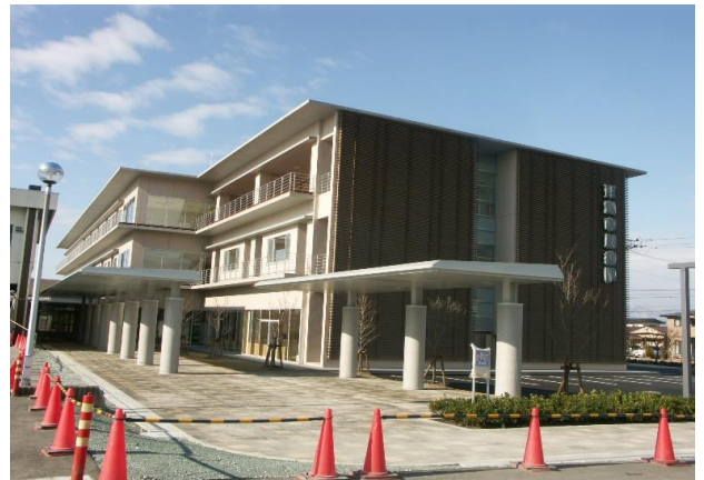
天童市立天童病院新築機械設備工事 H18.8～H19.12
