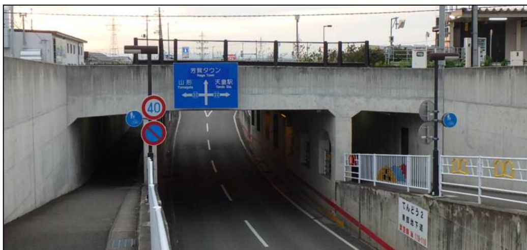
市道 松城芳賀線 南部地下道
